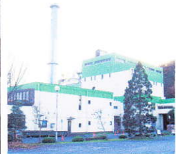
クリーンセンター (広域化要望中)
