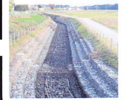
南小畦川 改修工事
